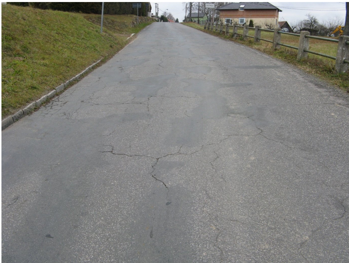
km 0,025+ Mozaikové a nepravidelné rozvětvené trhliny, síťové trhliny u okraje vlevo, vysprávkky tryskovou metodou, nepravidelné hrboly.
