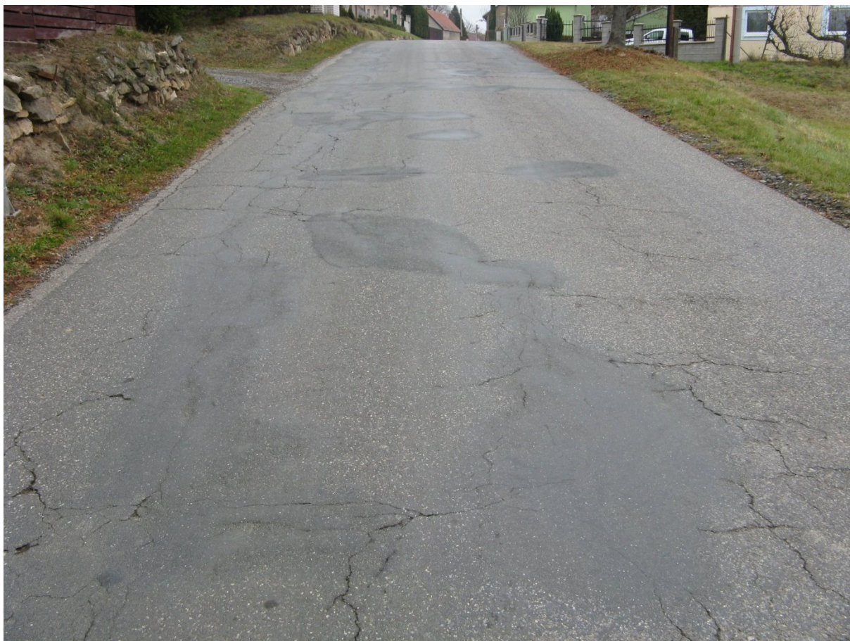
km 0,075+ Mozaikové a nepravidelné rozvětvené trhliny, vysprávkky tryskovou metodou, nepravidelné hrboly.
